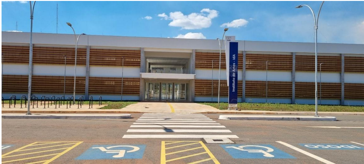
Foto da Fachada do Prédio do Instituto de Artes:
